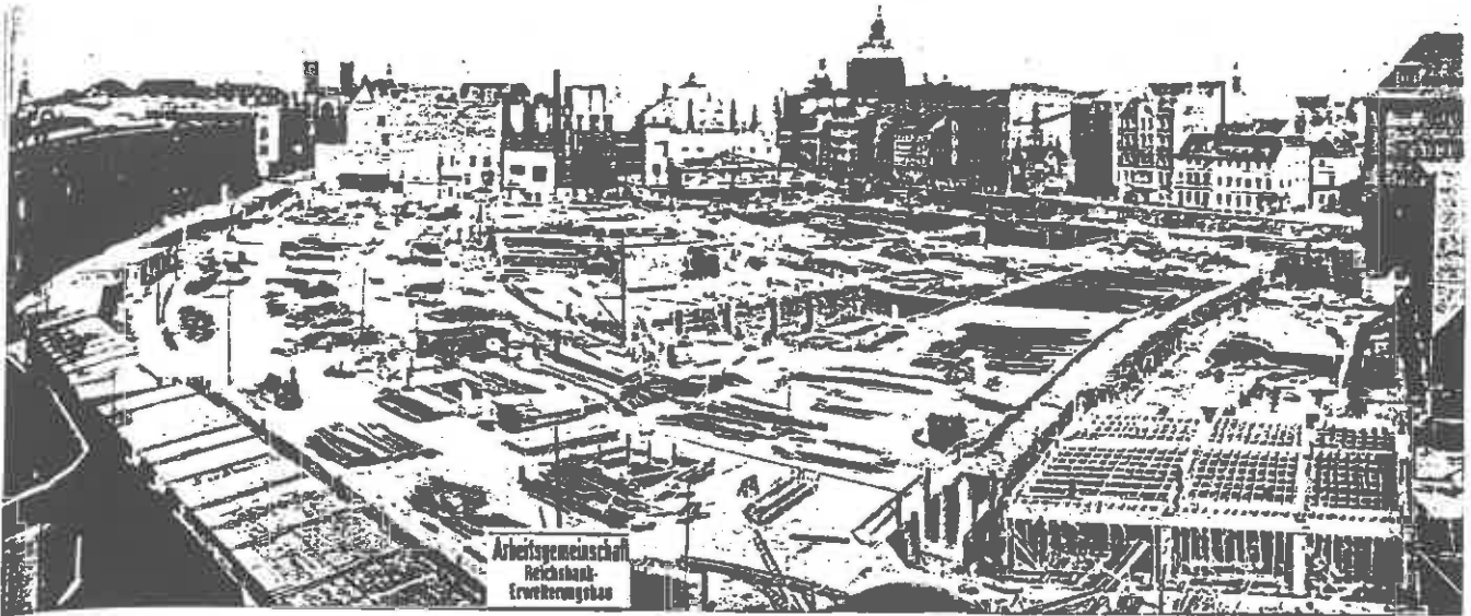
Fortgeschrittene Tiefbauarbeiten für das neue Gebäude der Reichsbank (Bauwelt 34/1937)
