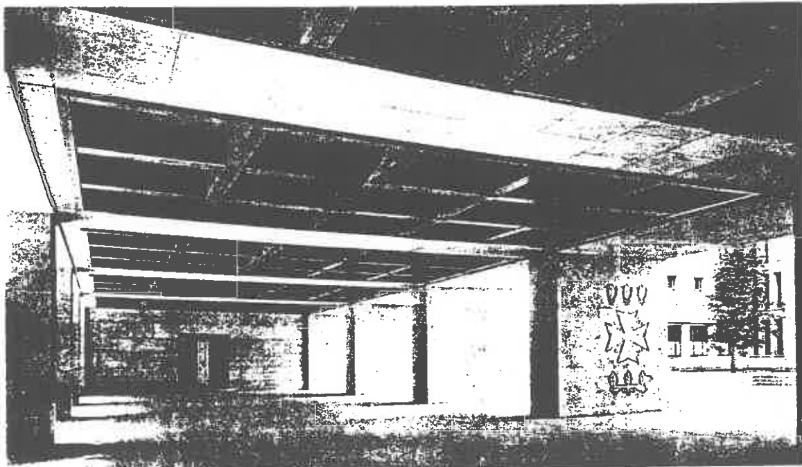
Der "Ehrenhof" an der Wilhelmstraße (oben) und einer der damals offenen Hofdurchgänge (unten) (Rittich 1938; Bauwelt 8/1937)
