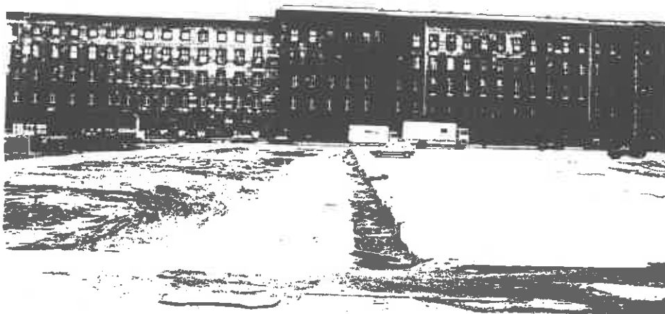
Treuhandgebäude: Baufront an der früheren Wilhelmstraße, Januar 1993. Deutlich wird, wie stark die künftige Bebauung auf der Ostseite der Straße den Eindruck bestimmen wird. (Gruppe DASS)
