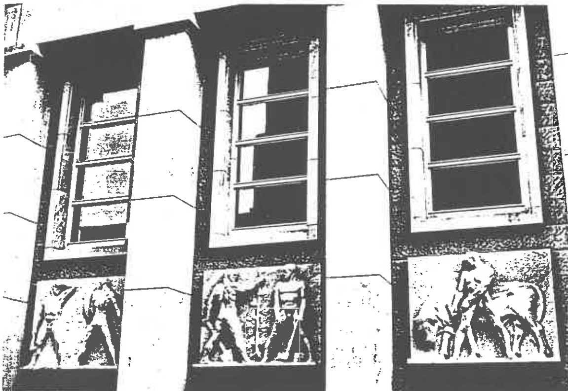
Bild oben: die zum alten Spreearm hin gelegene Ostseite des Reichsbankneubaus an der Unterwasserstraße. "Rechts der noch abzubrechende Bau der Münze. Der Fries von Schadow ist bereits entfernt, um in das neue Münzgebäude am Molkenmarkt eingefügt zu werden." (Bauwelt 34/1937) Bild unten: Hauptfront des Reichsbankneubaus mit drei Reliefs von Josef Thorak (Rittich 1938)
